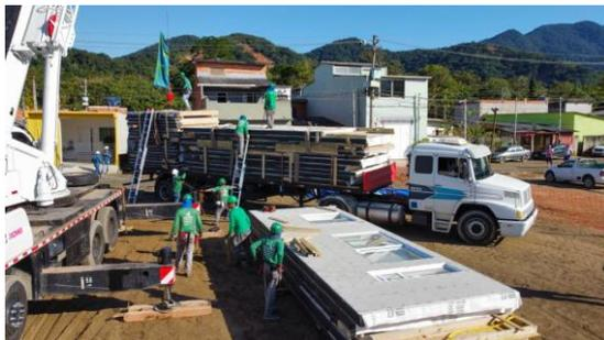
O que permite realizar as obras em menos tempo do que uma construção convencional é que os painéis que vão compor as moradas já saem prontos da fábrica. Cada uma delas possui sete camadas de materiais com propriedades diferentes.
