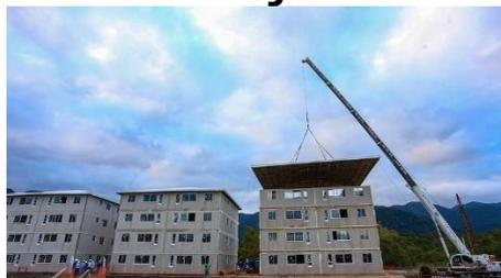
As moradias pré-fabricadas que estão sendo erguidas no bairro da Baleia Verde, em São Sebastião, contam com módulos de estrutura reforçada em sete camadas, o que torna as paredes impermeáveis e resistentes ao vento e à maresia.
