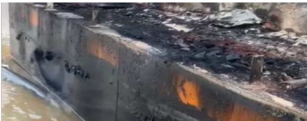
É possível ver marcas de incêndio na draga - Reprodução/Prefeitura de São Sebastião
