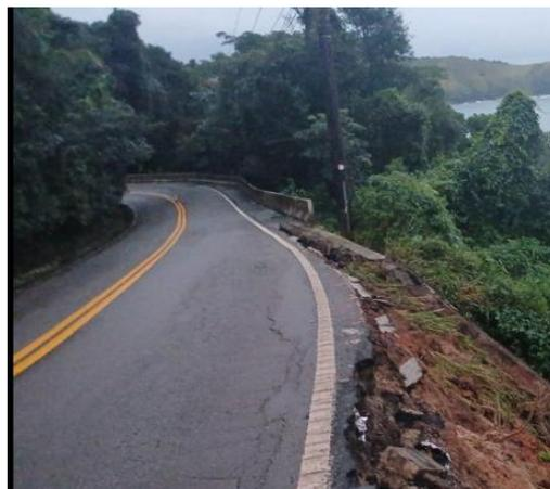
O trecho da rodovia Rio-Santos, na altura do km 145+800, entre as praias de Calhetas e Toque-Toque Pequeno, na costa sul de São Sebastião, está operando em sistema pare e siga, devido a um deslizamento de uma encosta, provocado em decorrência das chuvas e do solo encharcado.
