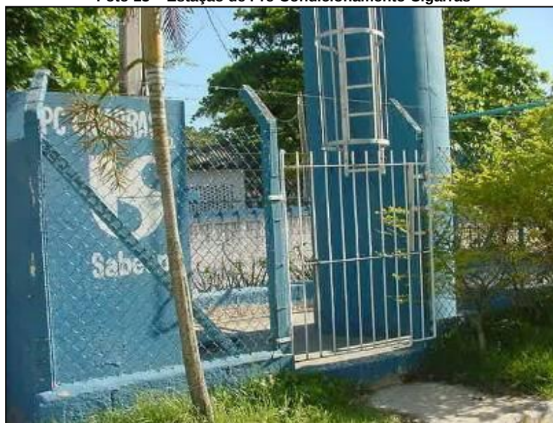
Foto 13 – Estação de Pré-Condicionamento Cigarras
