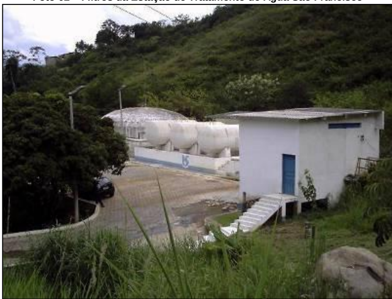
Foto 02 – Filtros da Estação de Tratamento de Água São Francisco
