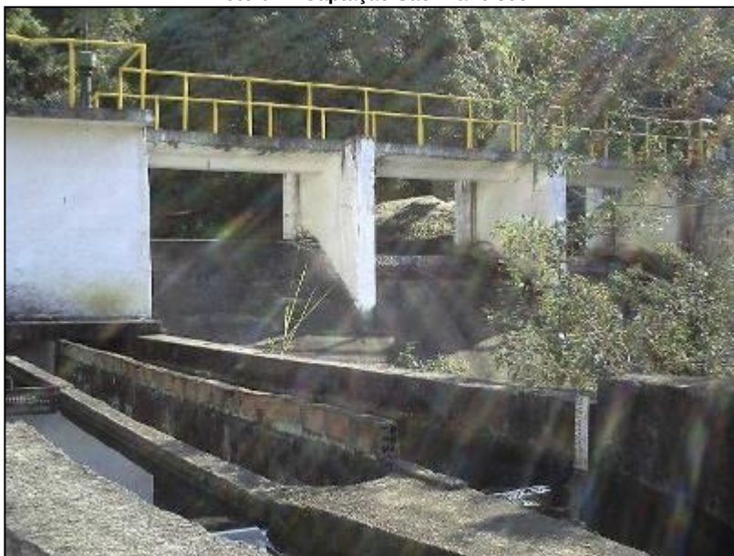
Foto 01 – Captação São Francisco
