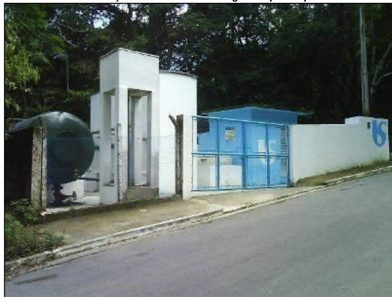
Foto 05 – Estação de Tratamento de Água Toque Toque Grande
