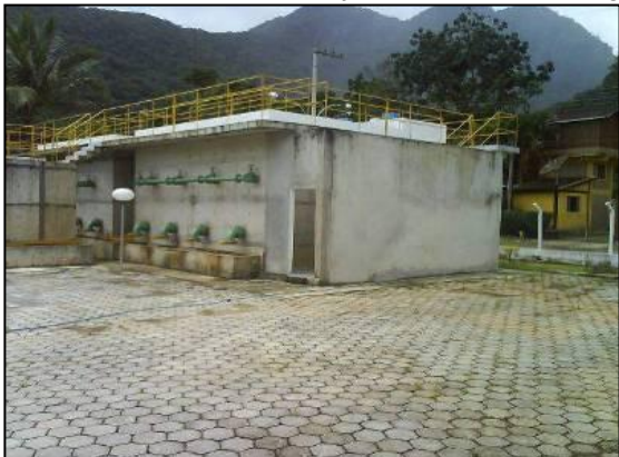
Foto 07 – Módulo de Tratamento da Estação de Tratamento de Água Maresias
